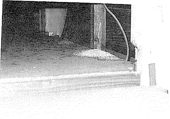
写真1 天井裏に排出された アメリカカンザイシロアリの糞
