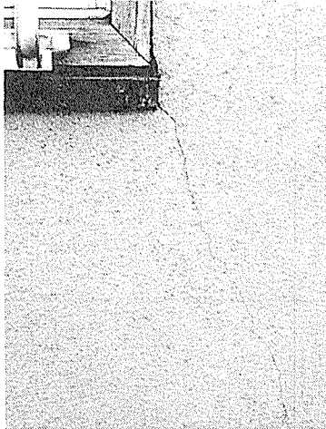
写真4.1-7 モルタル壁のひび割れ。開口部隅にはこのような斜めひび割れが多く見られる
