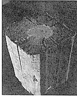
腐朽による大引の変色（褐色）
