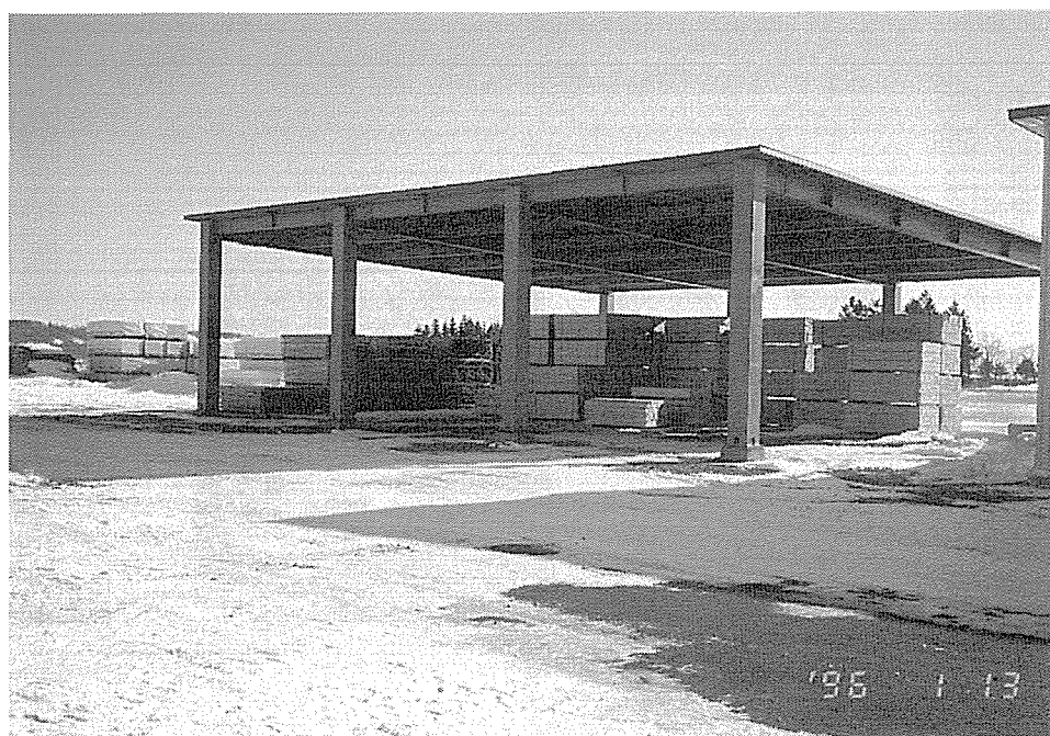
写真-14 製品保管施設
