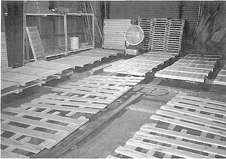
写真-9 塗 装 工 程
