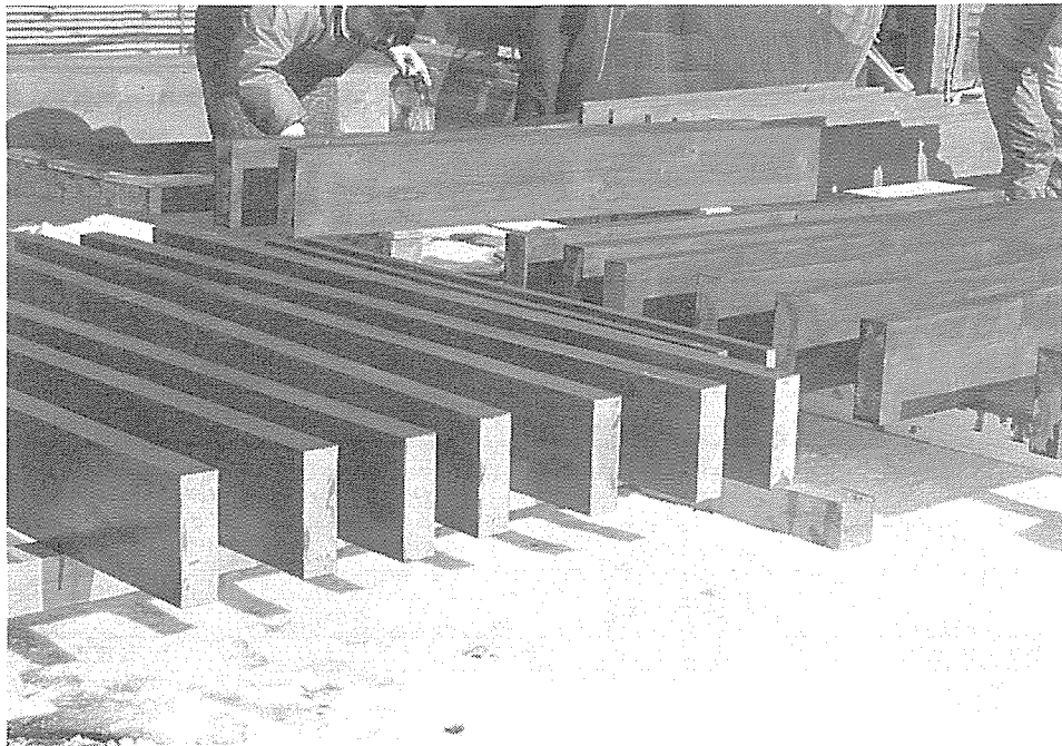
写真-8 塗装作業
