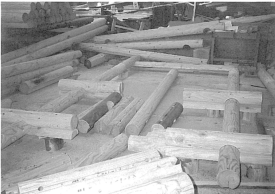
写真-6 円柱仮組み
