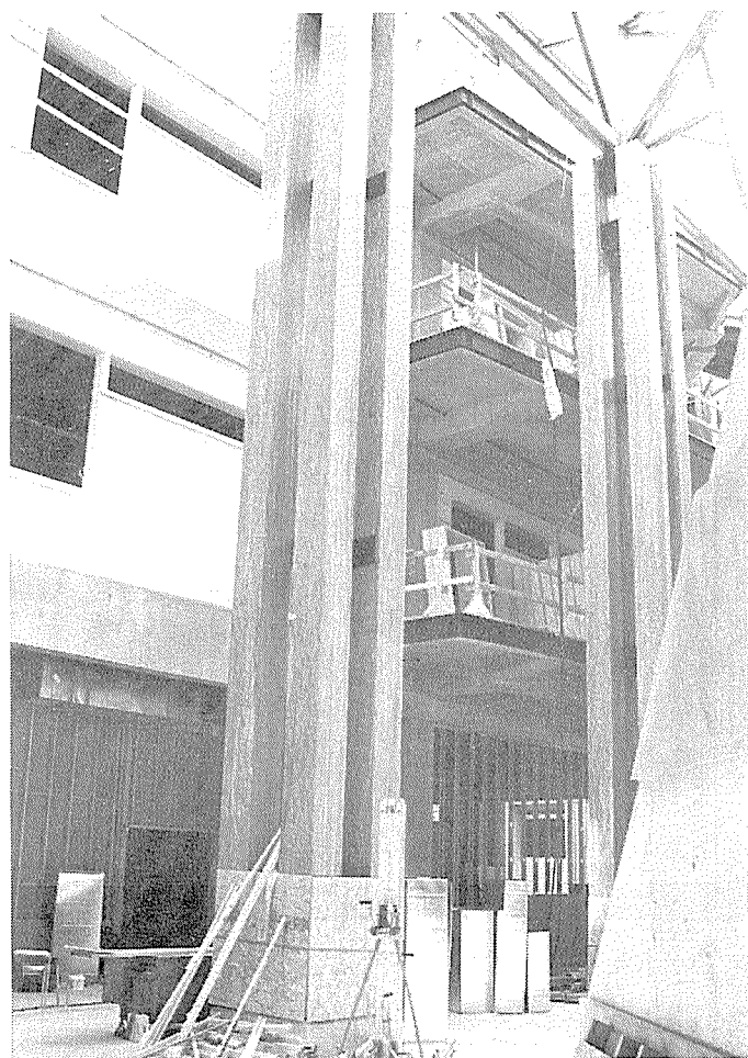
写真2.1-6 混構造建物内のパララムによる架構
