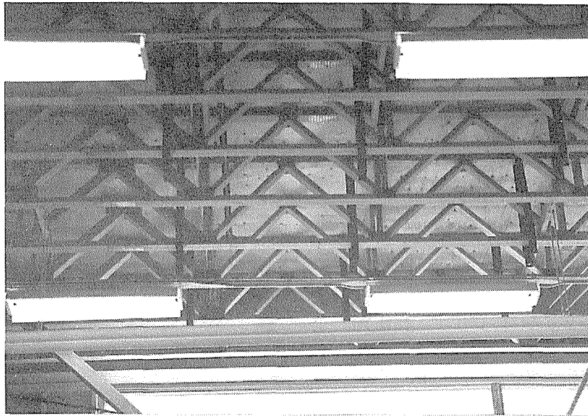
写真2.3-6 実験棟の小屋組トラス
