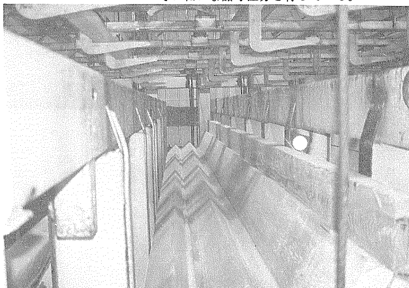
写真1.2-9 品等区分された材がバケットに自動的に収納される。
