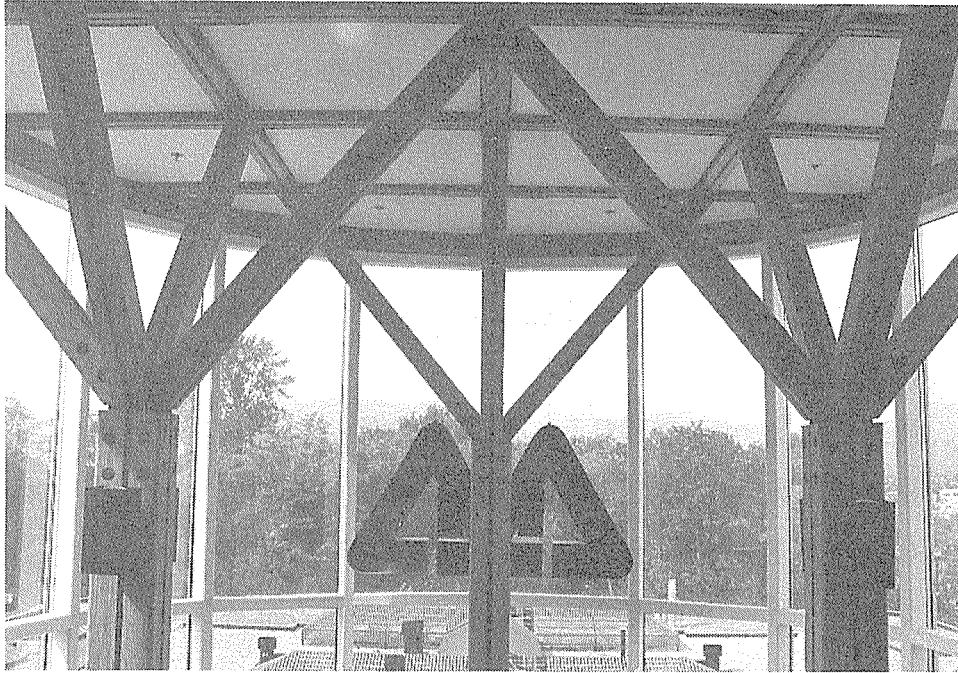
写真2.4-2 研究所内部木造架構
