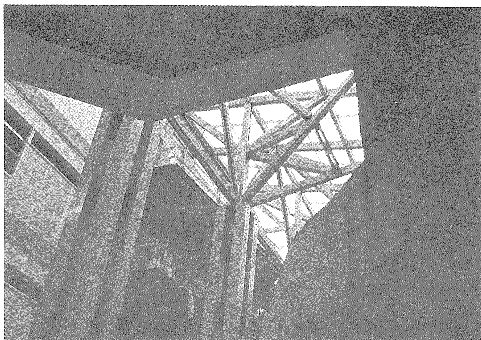
写真2.1-7 上部のトラス構造
