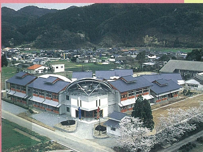
若木小学校(佐賀県武雄市)
