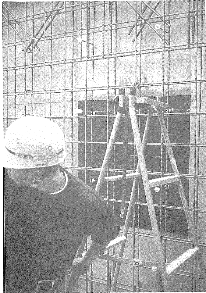
写真2-10 再生コンパネの組み立て。コンクリート打ち込み面。黒い色の板。
