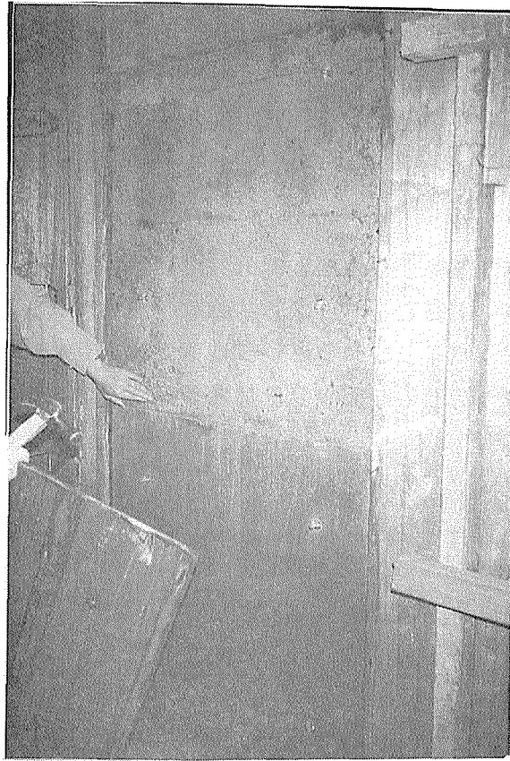
写真2-13 再生コンパネのコンクリート打設面 。上部、再生コンパネ面。下部、通常のコンパネ面。
