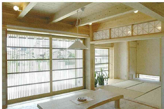
柱・梁の構造材を表わしにする
