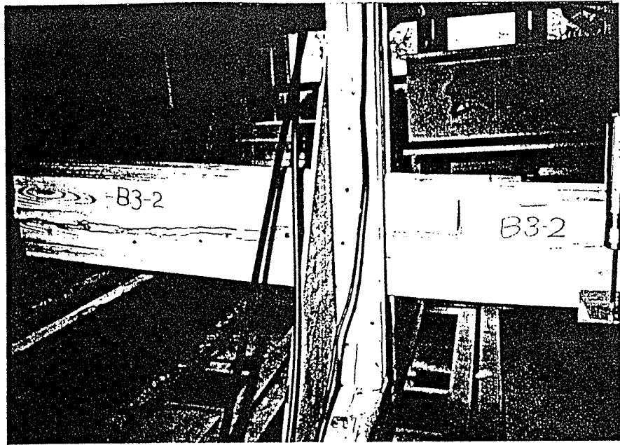
B 3 スギバットジョイント部の剪断破壊
